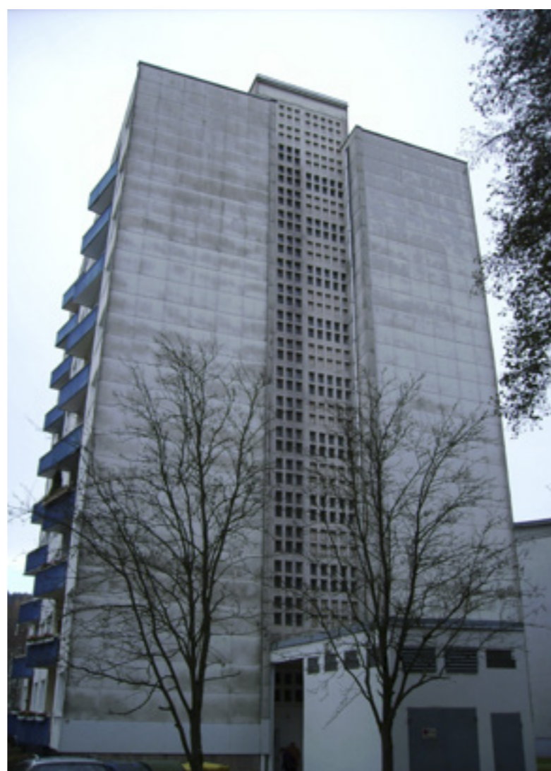
Haus 42 vor Sanierung | Foto: Sabine Steiner
