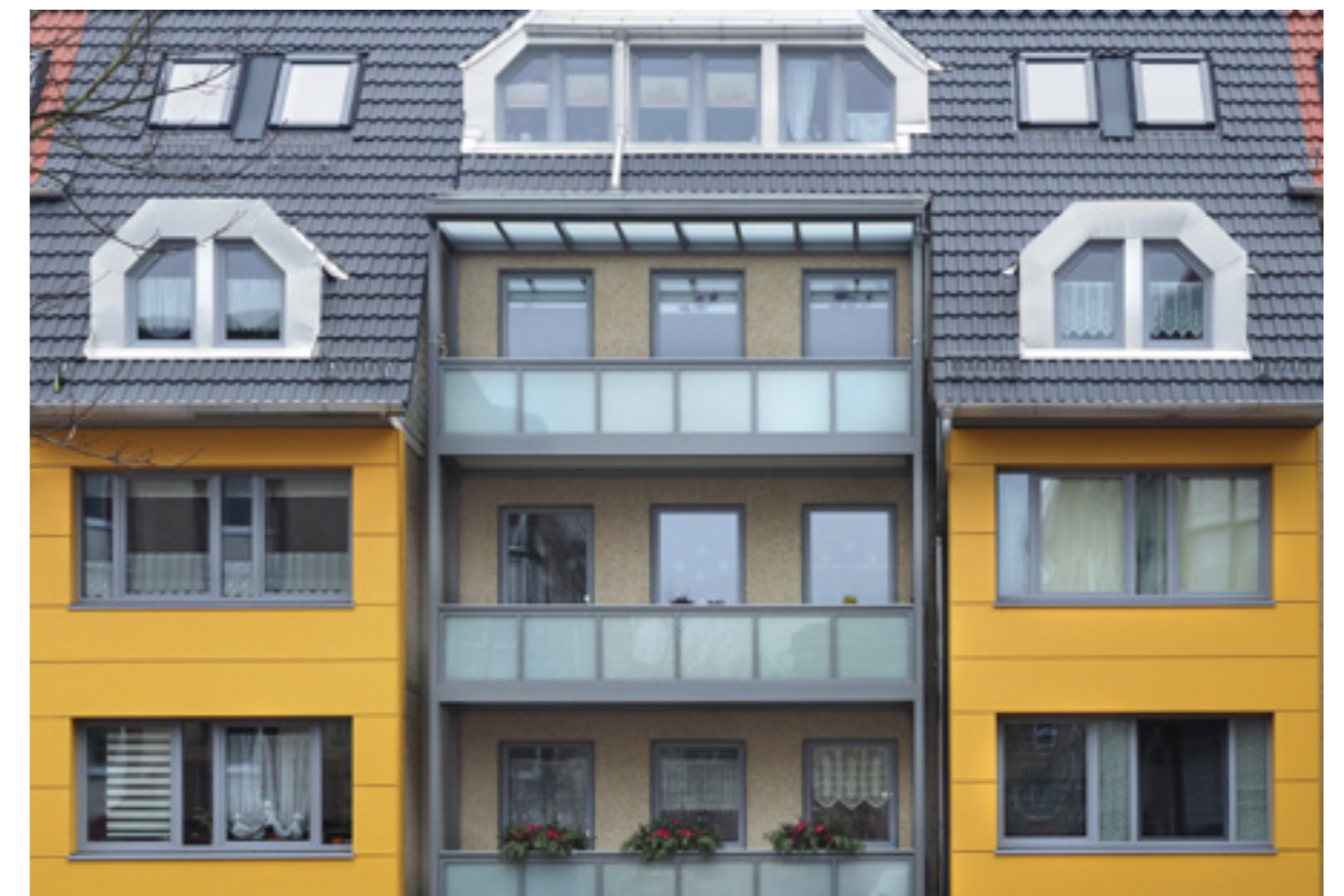
Neue Suhler Mitte/Fassade Details nach Sanierung | Foto: GeWo
