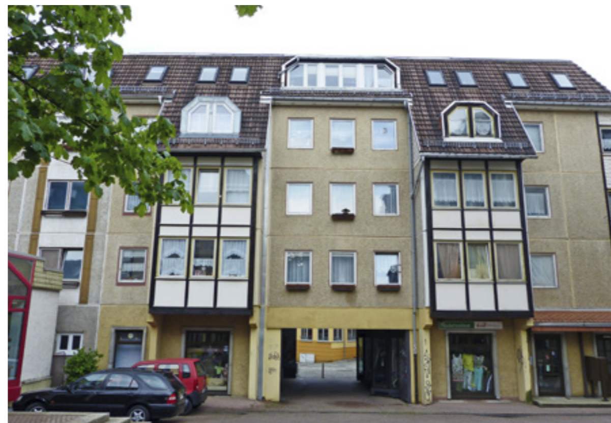
Neue Suhler Mitte/Fassade vorher | Foto: GeWo
