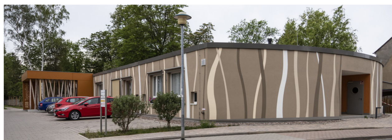
Umgebaute Bettenstation BA 01 - Betreutes Wohnen; Projektschau
