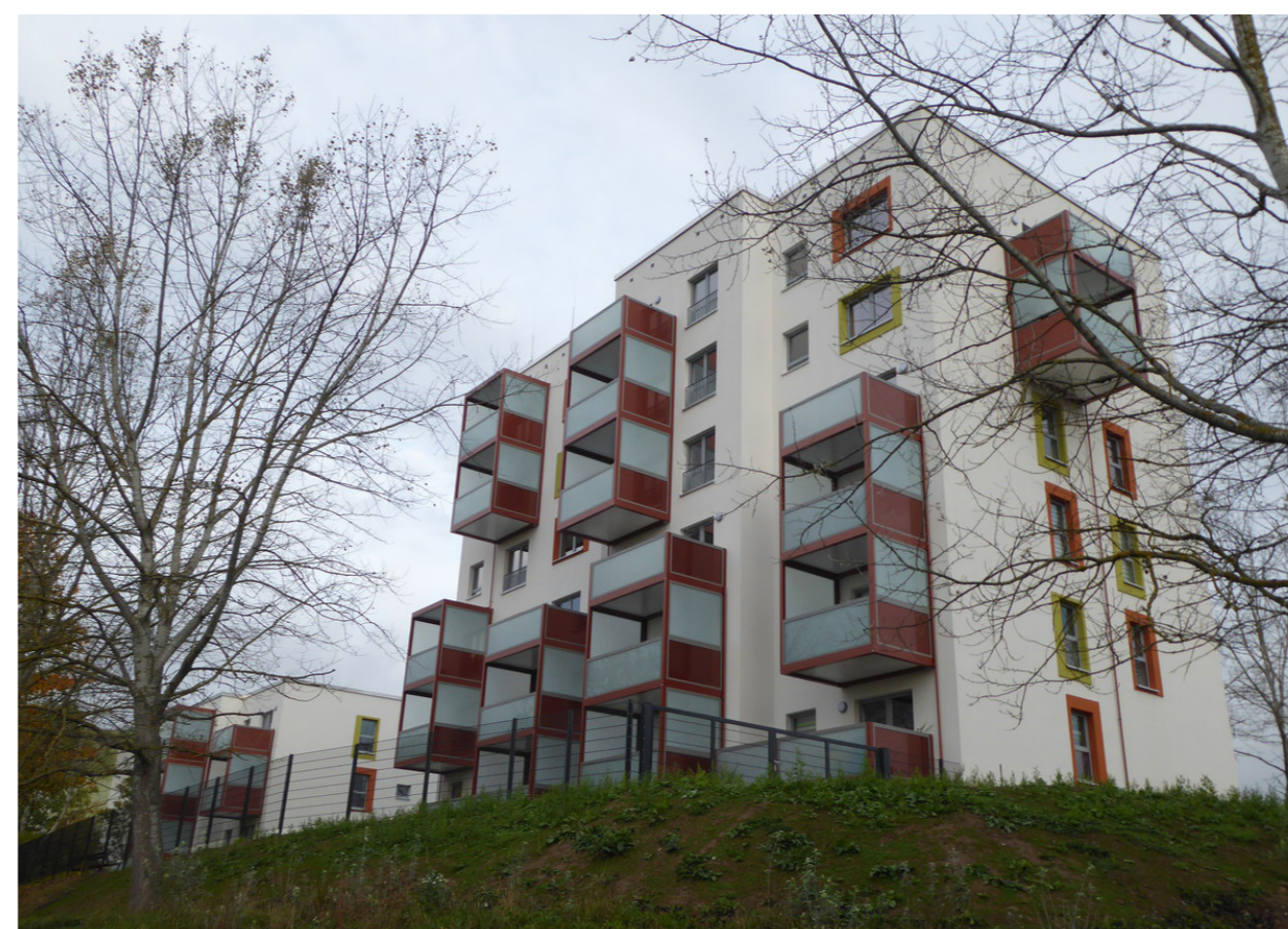
Gesamtansicht Allendestraße 77 bis 83 aus Südosten; Dr. Claus Untermann
