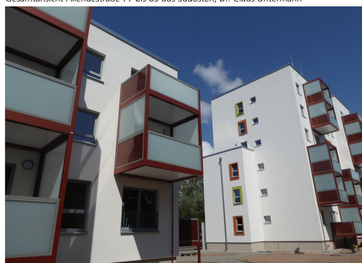
Blick von der Allendstr. 77 über den neuen Freiraum zur Allendstr. 81; Dr. C. Untermann
